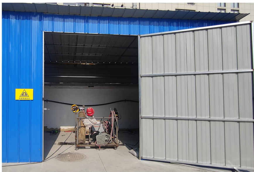
一般工业固体废物暂存间
